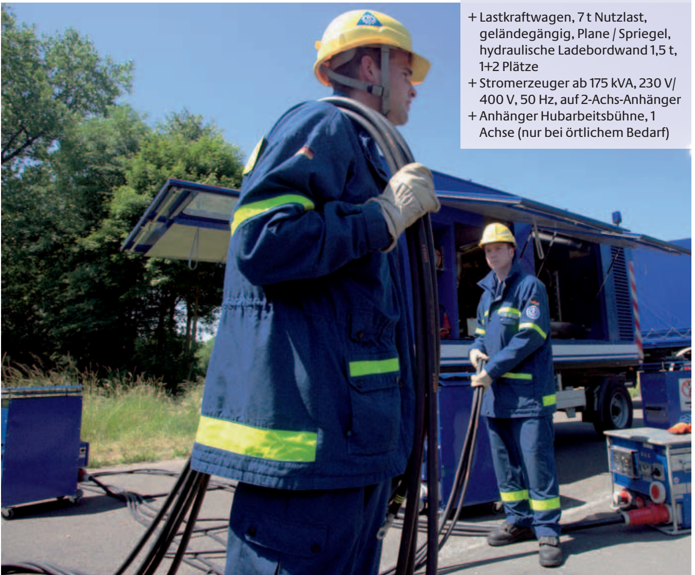
Die Fachgruppe Elektroversorgung kann vorübergehend einen größeren Energiebedarf abdecken.
